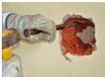
Esecuzione della traccia
