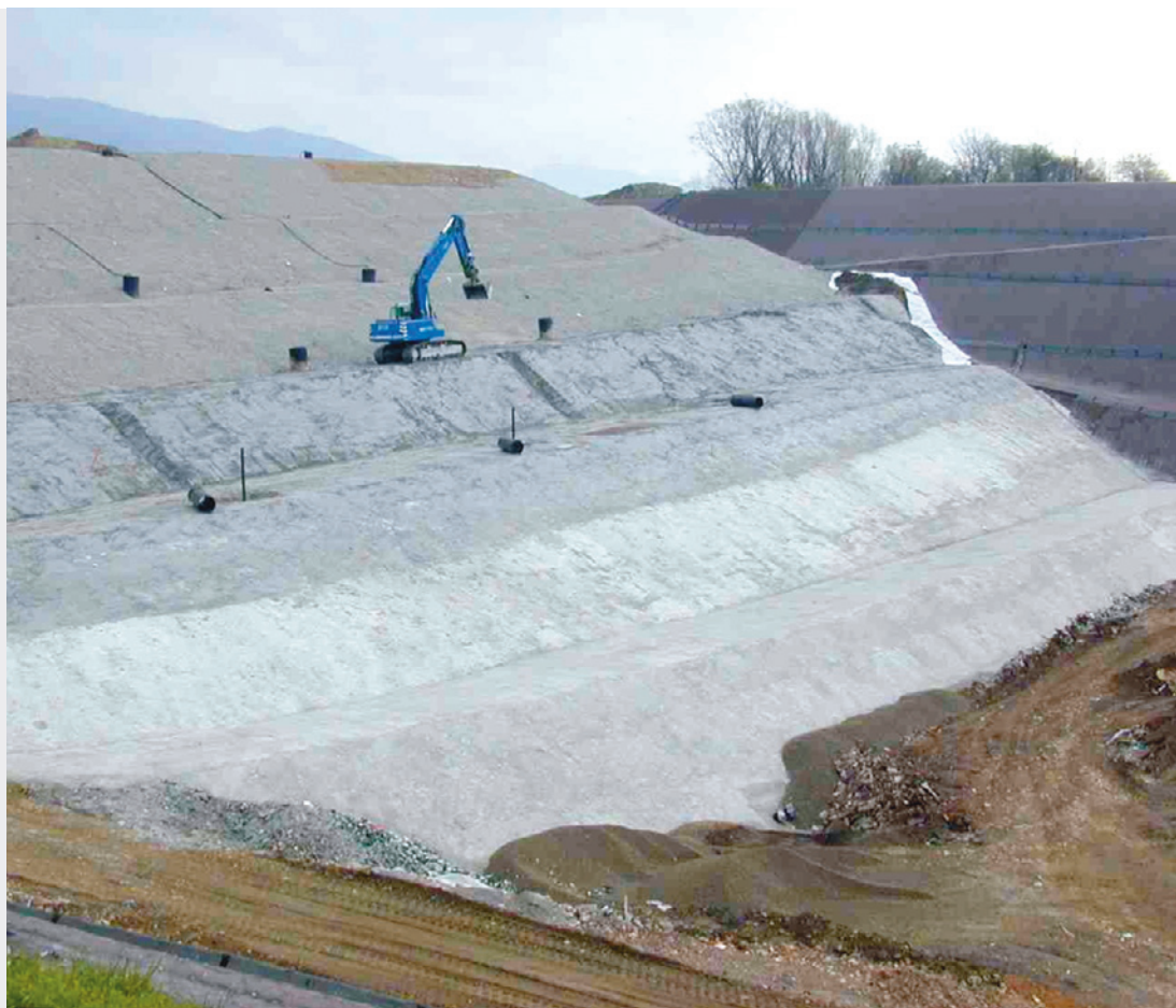
Capping di discarica realizzato con terreno contaminato trattato con Lipidur®
