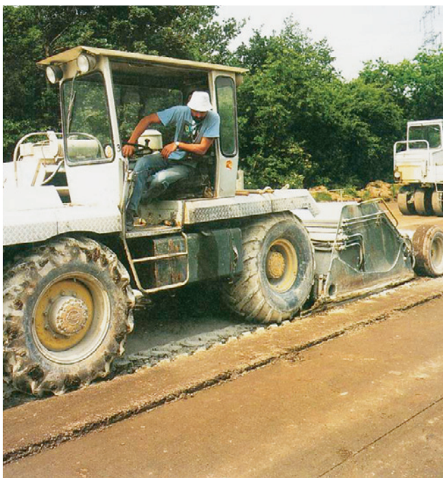
Procedimento mixed in place -miscelazione di Lipidur® 289
