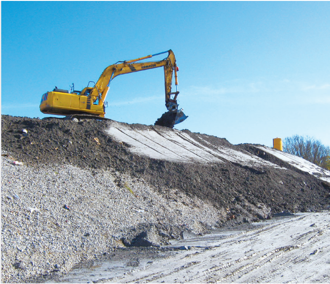
Formazione di capping in discarica.
