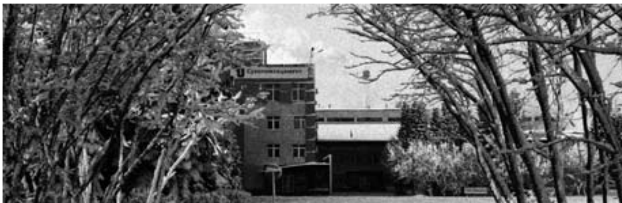
Stabilimento di Suchoi Log in Russia
