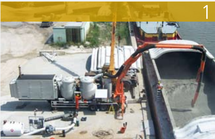
1. SCARICATORE DI CHIATTE KOVACO IN FUNZIONE CON UN CARICO DI CEMENTO KOVACO BARGE UNLOADER WORKING A BARGE OF CEMENT
