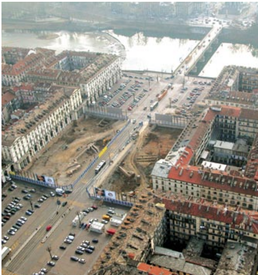
Vista aerea cantiere
