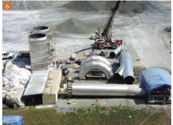
I componenti di pre-assemblaggio a terra. Pre-assembling parts on the ground.
