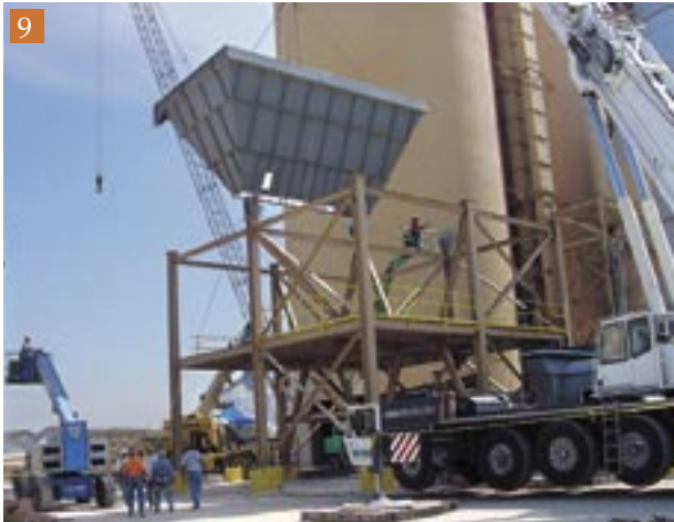
L'assemblaggio del corpo filtro.
