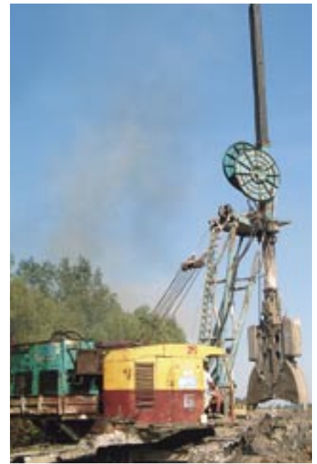
L'escavatore a benna mordente all'opera in cantiere.
