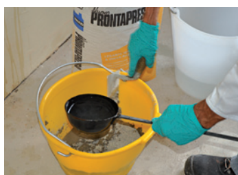
Dosaggio di acqua fino al raggiungimento della consistenza necessaria
