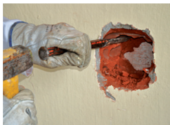
Esecuzione della traccia
