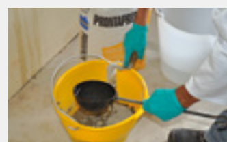
Dosage d'eau jusqu'à la consistance nécessaire
