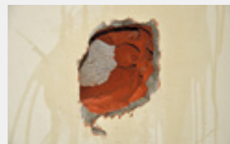
Humidification des surfaces et élimination des parties friables ou en cours de détachement
