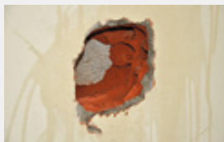
Humidification des surfaces et élimination des parties friables ou en cours de détachement
