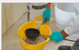
Dosage d'eau jusqu'à la consistance nécessaire
