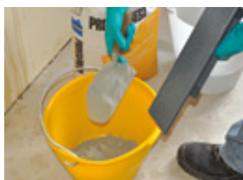
Dosaggio di PRONTAPRESA secondo le necessità
