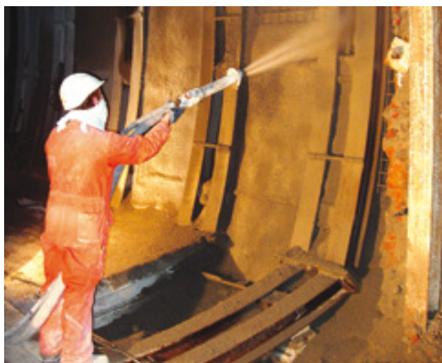
Consolidamento di galleria con centine
