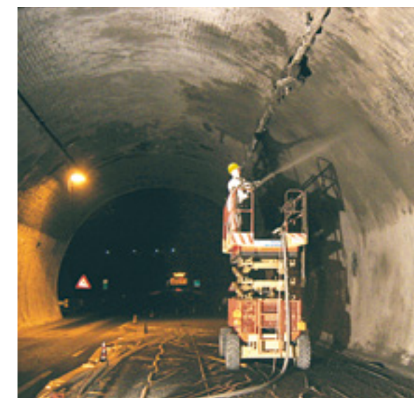
Ristrutturazione di gallerie autostradali in presenza di traffico
