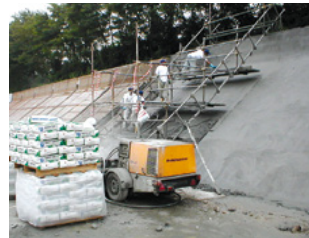
Fase di posa con finitura a frattazzo
