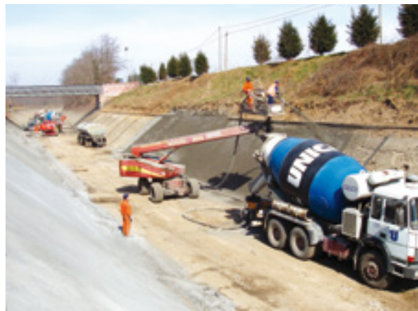
Fornitura della malta con miscelazione del legante in centrale di betonaggio
