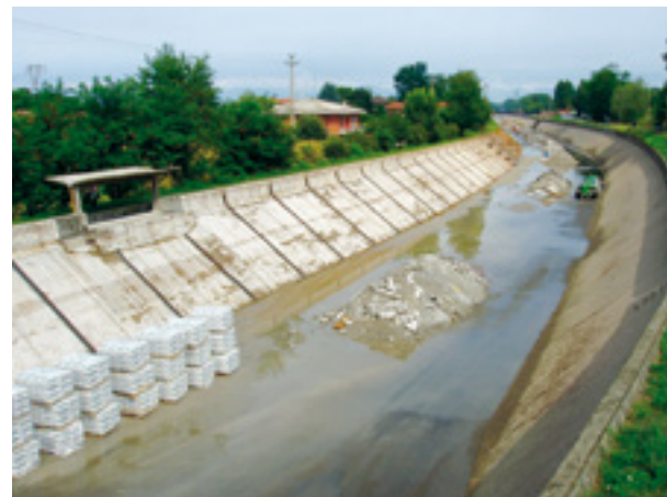
Ripristino di sponde di canale
