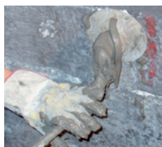
Fase di iniezione della malta Eco T 55
