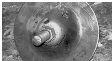
Particolare del chiodo CT-BOLT: piastra d'acciaio per la ripartizione dei carichi
